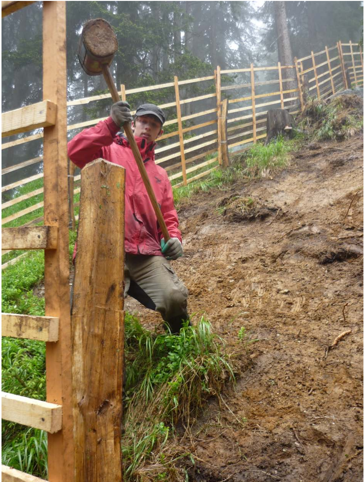
Tim haut mächtig drauf.....damit der Pfosten aus Kastanienholz 10 Jahre lang der Witterung ( u.a. enormer Schneedruck) standhalten wird.
